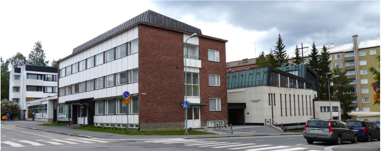
Suunnittelualue kuvattuna Kalevonkadun ja Yrjönkadun kulmasta. Vasemmalla kerrostalo-osa (ns. Nunnala) ja oikealla matalampi kirkkorakennus (06/2019).
